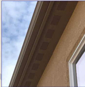
The Soffit Vent
